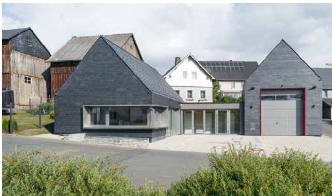
Das Dorfgemeinschaftshaus in Carlsgrün (Markt Bad Steben, Landkreis Hof) erhielt im Herbst den „Bayerischen Staatspreis für Dorferneuerung und Baukultur 2023“. Der Neubau mit Feuerwehrhaus stärkt die Qualität des zentralen historischen Dorfgangers.
